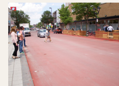
POUR ASSURER UNE MEILLEURE POSE DE LA PEINTURE DANS LA RUE ONTARIO, L'ARRONDISSEMENT MERCIER-HOCHELAGAMAISONNEUVE A PROCÉDÉ AU RESURFACÉ DE LA CHAUSSÉE. CÉPENDANT, L'ADHÉSION DU PRODUIT DE MARQUAGE N'A PU ÊTRE OPTIMALE EN RAISON DE CHALEUR EXTRÊME AU MOMENT DE LA POSE DU PRODUIT, ENTRAÎNANT UN PHÉNOMÈNE DE RESSUAGE 44 .
