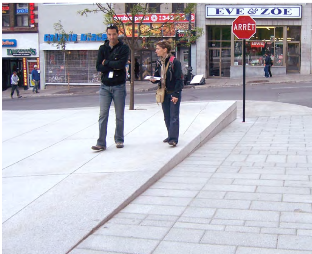
Photo 6 : Dénivellation non protégée par un garde-corps
