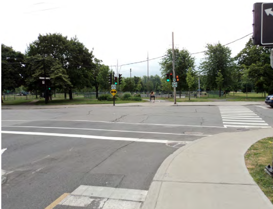
Photo 22 : Intersection en T : Trajectoires parallèles cyclistes/piétons; points d'arrivée distincts sur la barre du T
