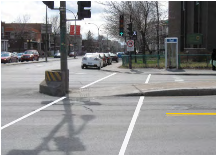
Photo 3 : Terre-plein avec muret de protection, à éviter
