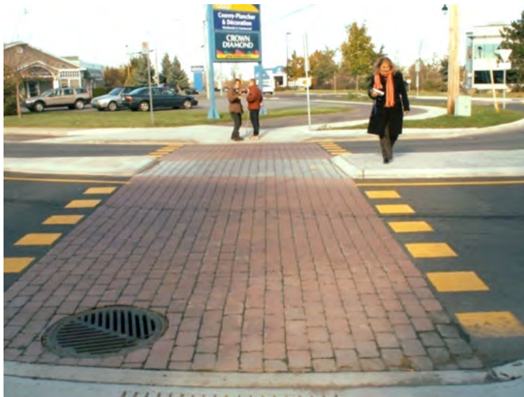
Photo 12 : Les deux segments forment une trajectoire rectiligne, mais l'entrée et la sortie de l'îlot séparateur ne sont pas détectables.
