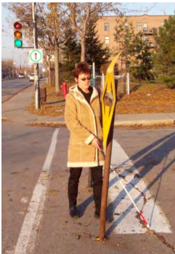
Photo 4 : Panneau de signalisation non détectable
