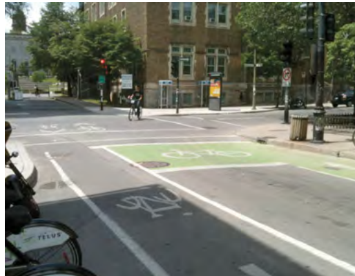
Photo 13b : Marquage de couleur offrant un espace d'attente pour les cyclistes et favorisant le respect du passage pour piétons
