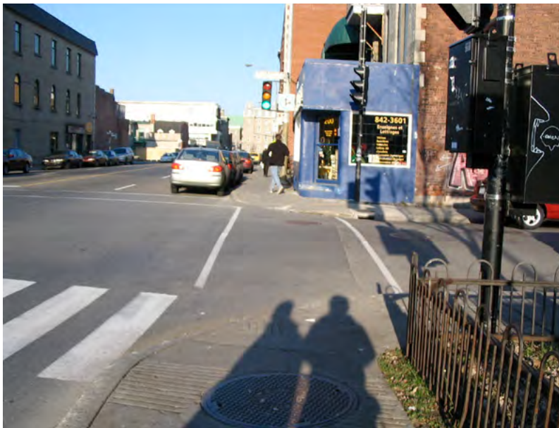
Photo 1 : Bateau pavé à l'intérieur du passage pour piétons
