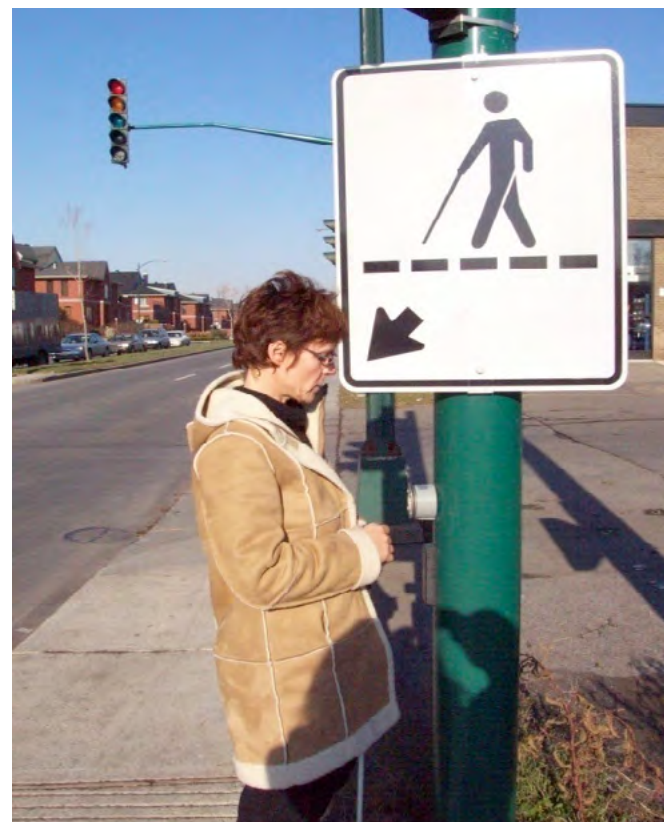
Photo 4 : Panneau de signalisation trop bas
