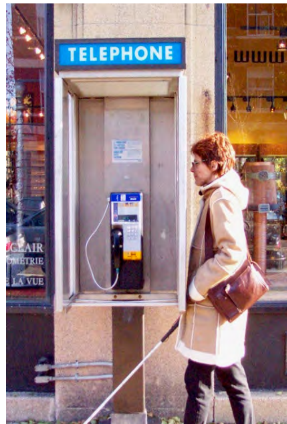
Photo 5 : Cabine téléphonique non détectable
