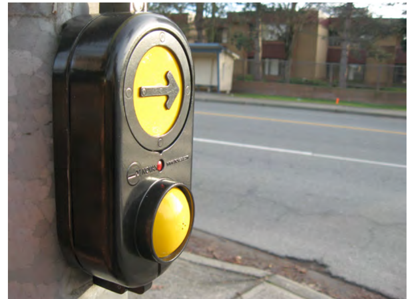
Photo 5 : Flèche en relief indiquant le sens de la traversée (Courtoisie Novax Industries)
