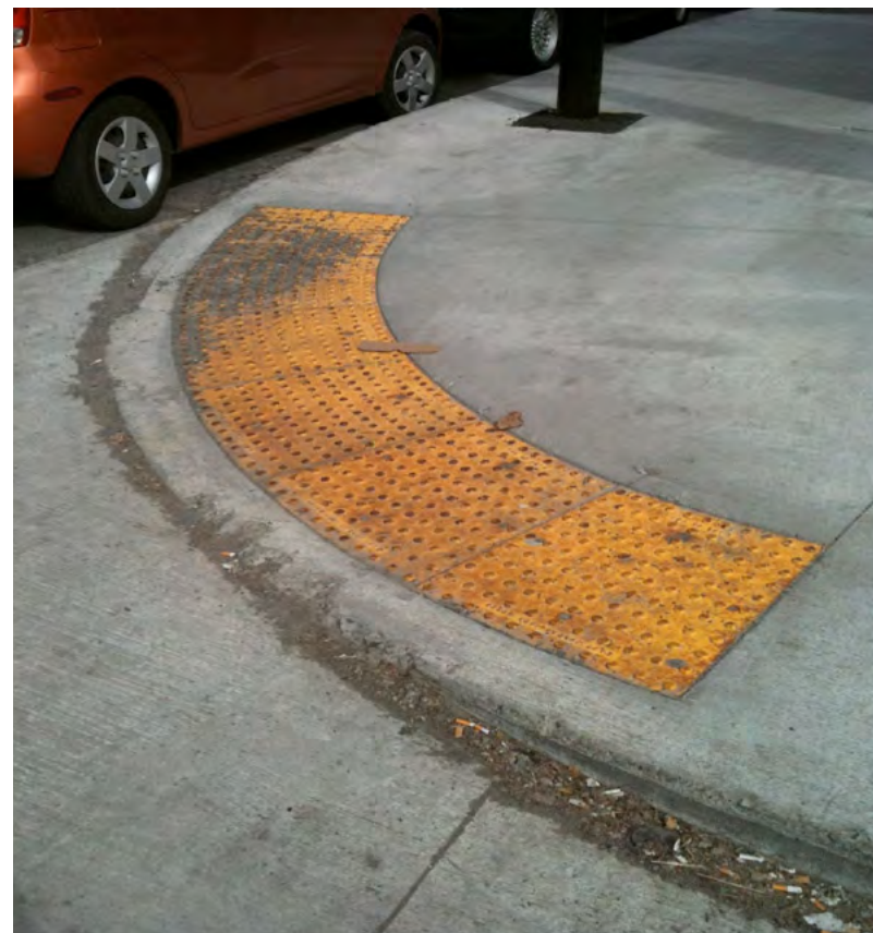
Photo 7 : Bateau pavé muni d'une surface avertissante
