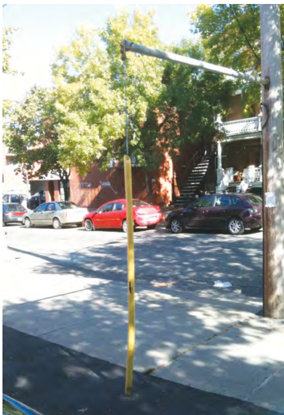
Photo 6 : Hauban vertical ne constituant pas un obstacle
