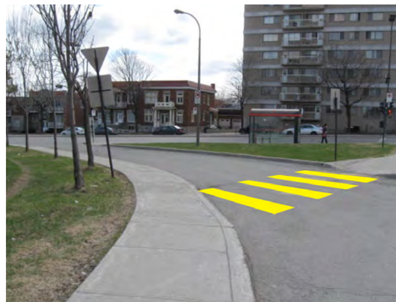
Photo 6 : Passage pour piétons non parallèle avec la voie routière
