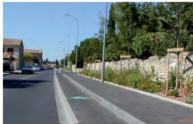
Photo 25 : Piste cyclable, à hauteur intermédiaire entre le trottoir et la rue, dite de Copenhague
