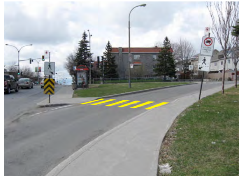
Photo 7 : Passage pour piétons en amont non rectiligne, avec le corridor piétonnier non parallèle avec la voie routière
